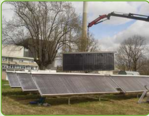
Aufbau der MEGA-Kollektorsegmente mit 78 Röhren für ein großes Solarkollektorfeld.
