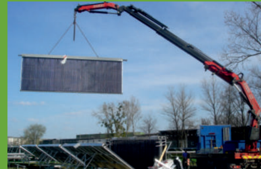
Aufbau der MEGA Kollektorsegmente mit 78 Röhren für ein großes Solarkollektorfeld
